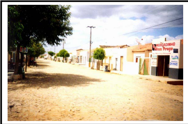
FOTO 01 – VISTA DO CAMINHAMENTO DA ADUTORA EM CALÇAMENTO DENTRO DO DISTRITO DE BETÂNIA
