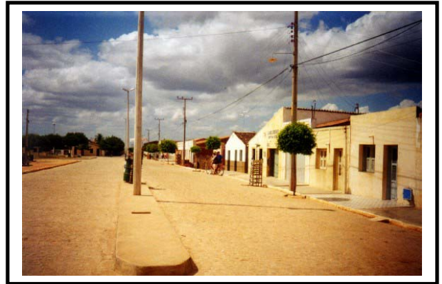
FOTO 02 – VISTA DO CAMINHAMENTO DA ADUTORA EM CALÇAMENTO DENTRO DO DISTRITO DE BETÂNIA
