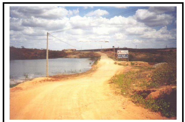
FOTO 04 – VISTA DA CHEGADA DA ADUTORA NA CIDADE DE DEP. IRAPUAN PINHEIRO
