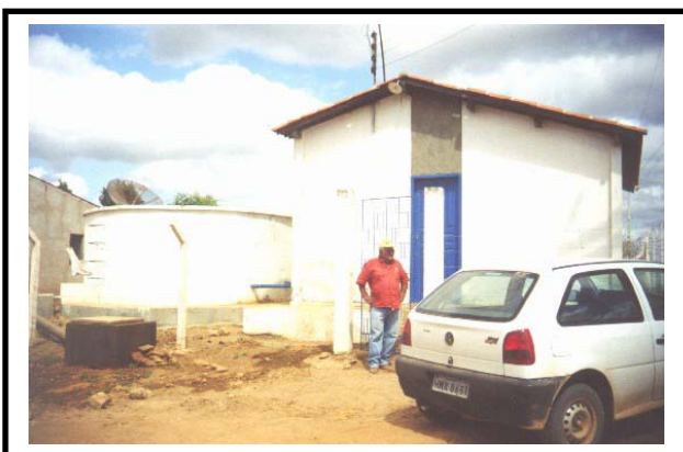
FOTO 03 – VISTA DA ETA EXISTENTE EM BETÂNIA
