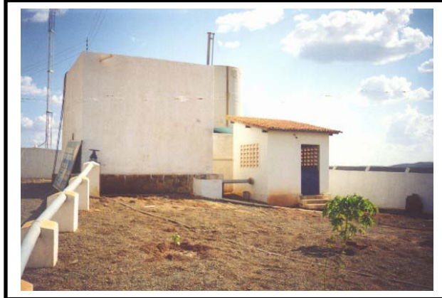
FOTO 01 – VISTA DA ETA EXISTENTE COM RESERVATÓRIO APOIADO, FILTRO E CASA DE BOMBAS PARA LAVAGEM DOS FILTROS, NA CIDADE DE DEP. IRAPUAN PINHEIRO
