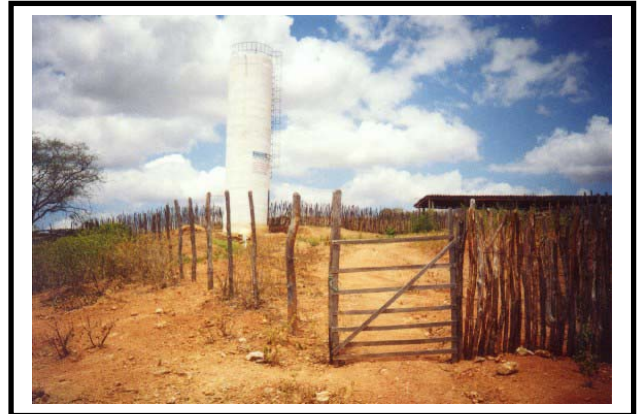
FOTO 14 – VISTA DO RESERVATÓRIO ELEVADO PARA O ABASTECIMENTO D'ÁGUA DE VELAME
