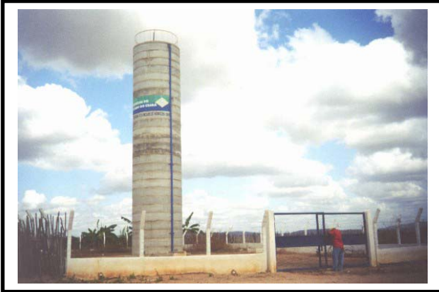
FOTO 05 – VISTA DO RESERVATÓRIO ELEVADO EXISTENTE EM BETÂNIA
