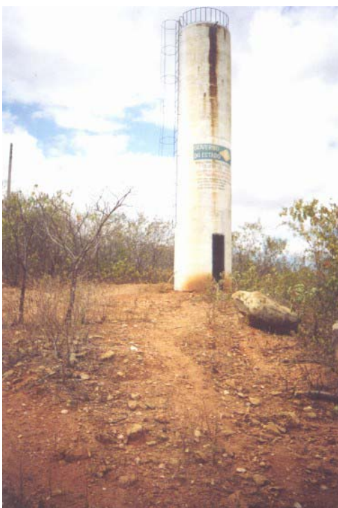
FOTO 11 – VISTA DO RESERVATÓRIO ELEVADO DO ABASTECIMENTO D'ÁGUA DE CACHIMBINHA
