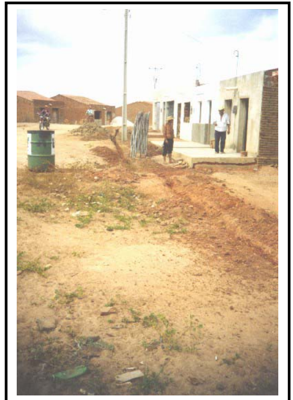
FOTO 06 – REDE DE ABASTECIMENTO SENDO IMPLANTADA NA SEDE DO DISTRITO DE BETÂNIA
