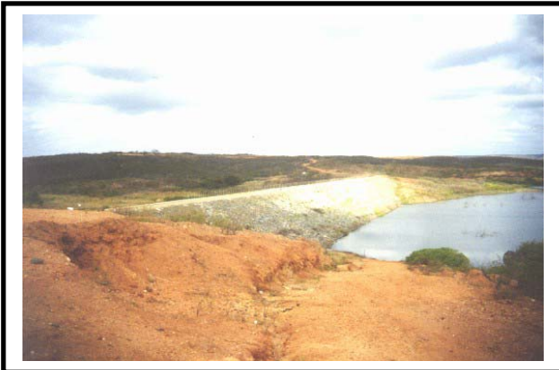
FOTO 01 – VISTA DA BARRAGEM A PARTIR DA ESTACA 0
